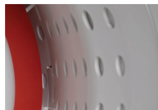
Isolamentos de dupla camada e perfuração para acústica
